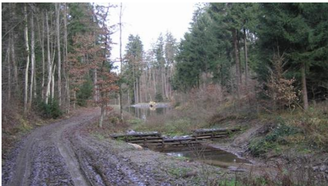
Obr. Příklad podélného zpevnění břehů lesní bystřiny
