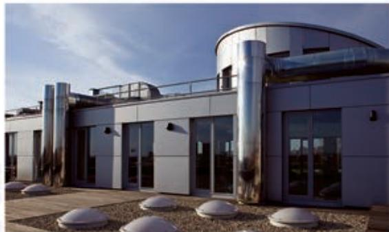
V prvním podlaží je použito prosklené opláštění, na které v horní části navazuje kamenná fasáda. Ta je z brazilských žulových desek, a to včetně atiky tvořící zábradlí terasy v úrovni nejvyššího patra objektu. Plocha kamenného obkladu je cca 5 200 m<sup>2</sup>. Konstrukce je řešena jako provétrávaná fasáda, která je přikotvena k železobetonové konstrukci. Ve světlíku je tvořena dibondovými sendvičovými deskami.
